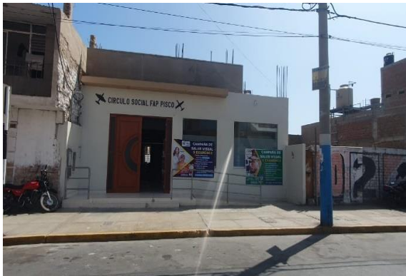
FACHADA DE LA FILIAL PISCO
